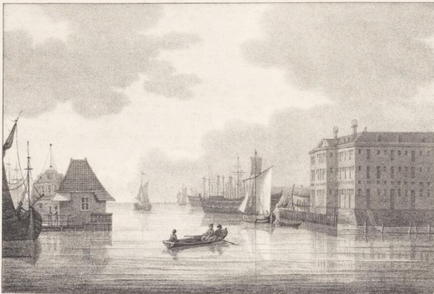
Le Chantier d'Amsterdam
